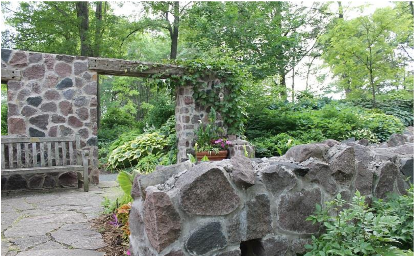
دیوار خشکه چین با سنگ قلوه رودخانه‌ای و نمای طبیعی
